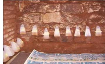
Bild zeigt die Trichtertränkung einer befallenen Wand
